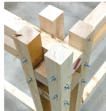
図1 柱と梁の接合部
