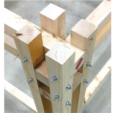
図1 柱と梁の接合部
